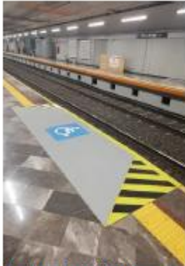
Reductores de Galibo (Rampas de andén a tren Vía 1 y Vía 2 (Concluido))
