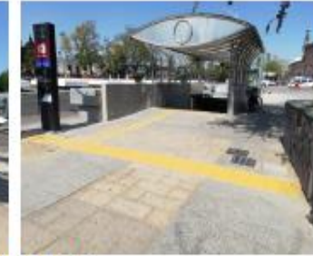
Guía podotáctil exterior en ingresos Vía 1 y Vía 2 (Concluido)
