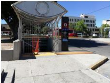
Guía podotactil exterior en ingresos Vía 1 y Vía 2 (Concluido)
