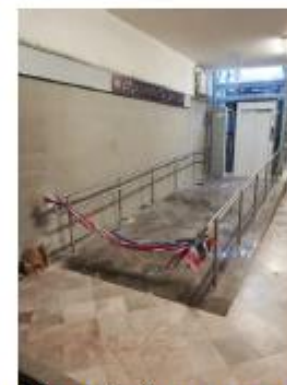
Elevador Vía 2 (En proceso de pruebas), pasamanos y piso en rampa (Concluido)
