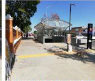
Guía podotáctil exterior en ingresos Vía 1 y Vía 2 (Concluido)
