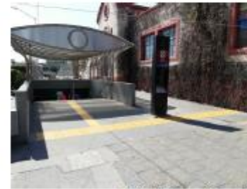
Guía Podotáctil en Ingresos Via 1 y Via 2 (Concluido)
