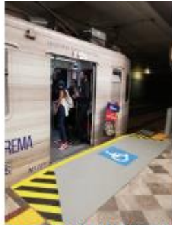
Reductores de Galibo (Rampas de andén a tren Vía 1 y Vía 2 (Concluido)
