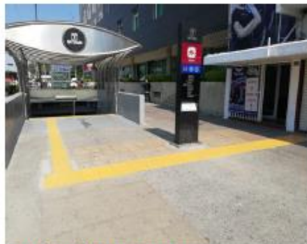
Guía podotactil exterior en ingresos Vía 1 y Vía 2 (Concluido)
