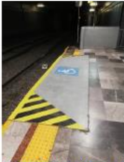
Reductores de Galibo (Rampas de andén a tren Vía 1 y Vía 2 (Concluido)
