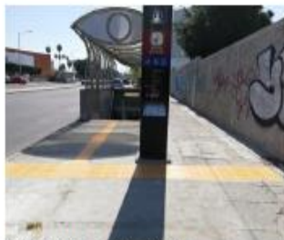
Guía Podotáctil exterior Ingresos Vía 1 y Vía 2 (Concluido)
