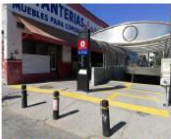
Totems informativos y placas braille Ingresos Vía 1 y Vía 2 (Concluido)
