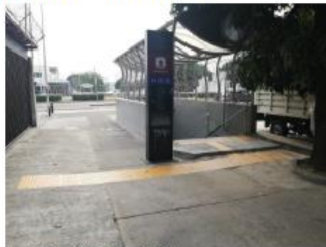
Guía podotactil exterior en ingresos Vía 1 y Vía 2 (Concluido)
