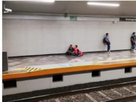
Reductores de Galibo (Rampas de andén a tren Vía 1 y Vía 2 (Concluido))
