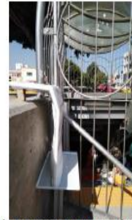
Servoescaleras ingresos sur Vía 1 y Vía 2 en proceso de instalación en sitio
