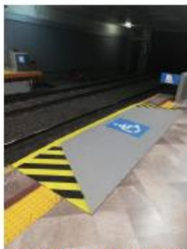
Reductores de Galibo (Rampas de andén a tren Vía 1 y Vía 2 (Concluido))
