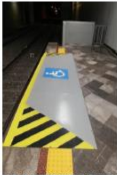
Reductores de Galibo (Rampas de andén a tren Vía 1 y Vía 2 (Concluido))
