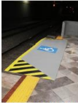
Reductores de Galibo (Rampas de andén a tren Via 1 y Via 2 (Concluido)
