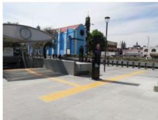
Guía podotáctil exterior en ingresos Vía 1 y Vía 2 (Concluido)
