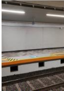
Reductores de Galibo (Rampas de andén a tren Vía 1 y Vía 2 (Concluido))
