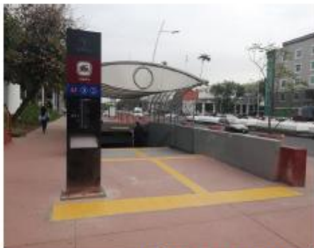
Guía podotactil exterior en ingresos Vía 1 y Vía 2 (Concluido)
