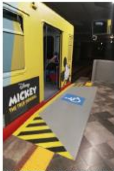
Reductores de galibo (rampas andén a tren) Vía 1 y Vía 2 (Concluido)
