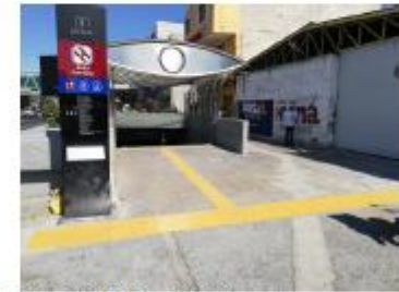
Guía Podotáctil en Ingresos Via 1 y Via 2 (Concluido)
