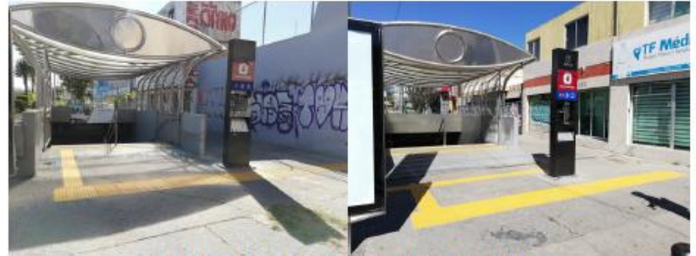
Guía podotáctil exterior en ingresos Vía 1 y Vía 2 (Concluido)
