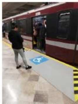
Reductores de Galibo (Rampas de andén a tren Vía 1 y Vía 2 (Concluido))
