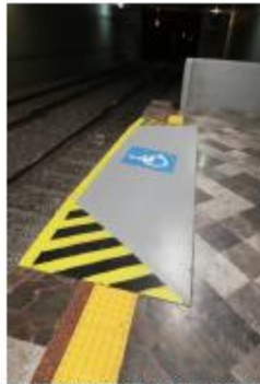
Reductores de Galibo (Rampas de andén a tren Vía 1 y Vía 2 (Concluido))
